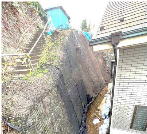
耐候性繊維落石防護網工
