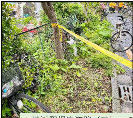
横浜駅根岸道路（左）への地盤の傾動と沈下
