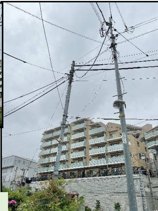
横浜駅根岸道路（左）への地盤の傾動と沈下
