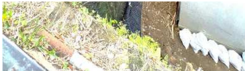
耐候性繊維落石防護網工
